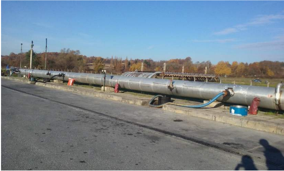
Slika 27. Pretakalište autocisterni
